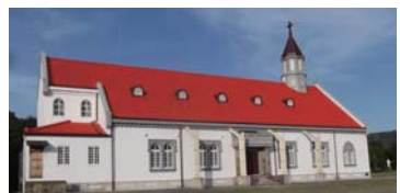
2007年4月に起工式を行ったザビエル記念旧聖堂（宗像市）の再生工事は現在、建物の外観が赤い屋根をふいてほぼ完成し、
