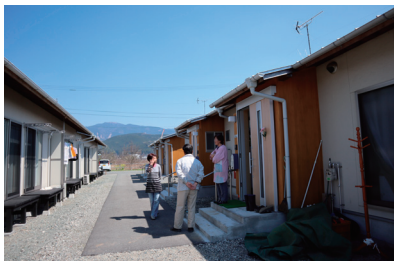
西原村小森の復興住宅。木造の仮設住宅を改修したもの、50戸がある。
